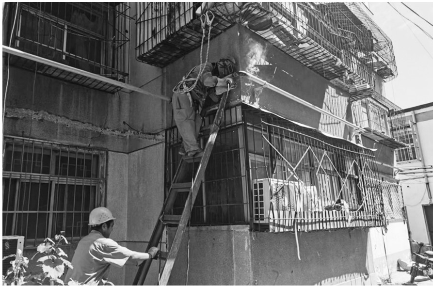
在郑州市南关街177号院,工作人员正在安装天然气管道
