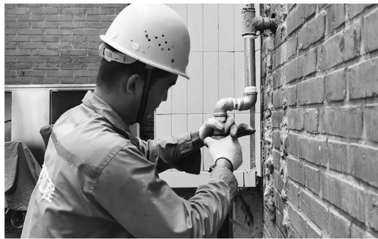
郑州市伏牛路139号院,工作人员对老旧管网进行改造
