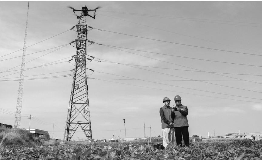
秋收在望,9月11日,国网温县供电公司组织焦裕禄共产党员服务队队员走进田间地头,通过无人机巡检方式,对涉农输配电线路开展全面“体检”,重点检查线路交叉跨越、拉线防撞标识等,及时做好线路隐患排查、杆塔根基加固、电网通道树障治理等工作,确保秋收期间农户用电安全。 乔明辉 乔冠楠
