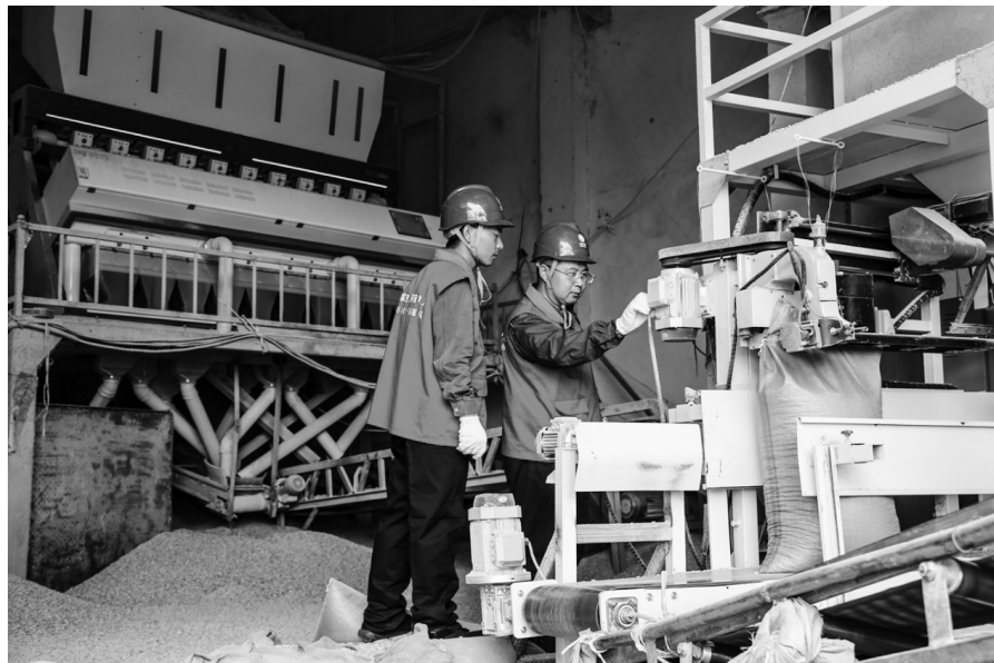
嵩县供电公司员工帮助用户排查用电设备隐患
