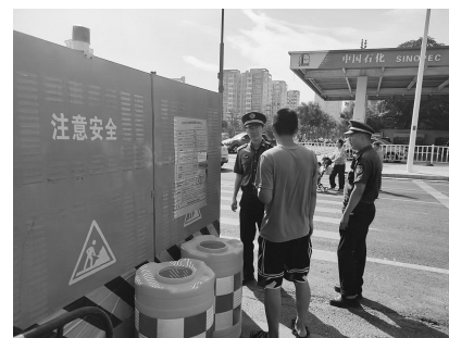
汛前市政施工围挡排查
