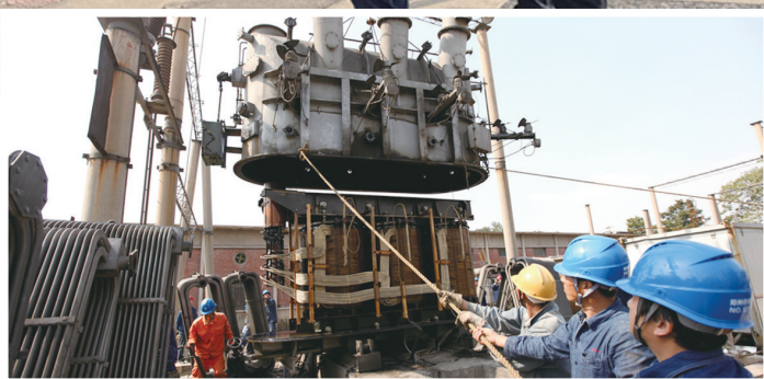
检修人员对老式变压器进行吊罩检修
