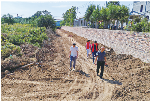
查看施工现场
