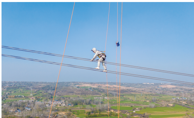
检修人员对500千伏瀛州I线开展带电更换绝缘子
