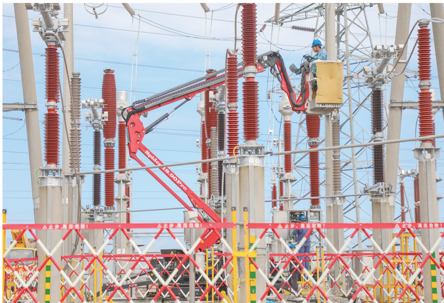
检修人员对500千伏嘉和变电站开展综合检修
