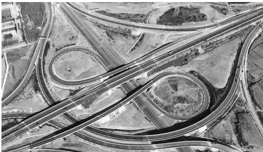
沿太行高速公路安阳段横水枢纽互通
