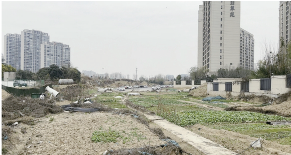
百荣路施工现场
