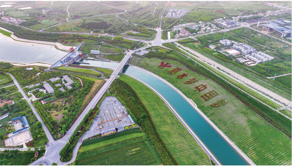
南水北调中线渠首
