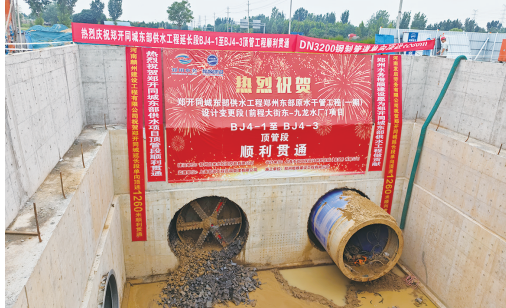
刷新省内大口径(直径3.2米)顶管施工最长顶距纪录
