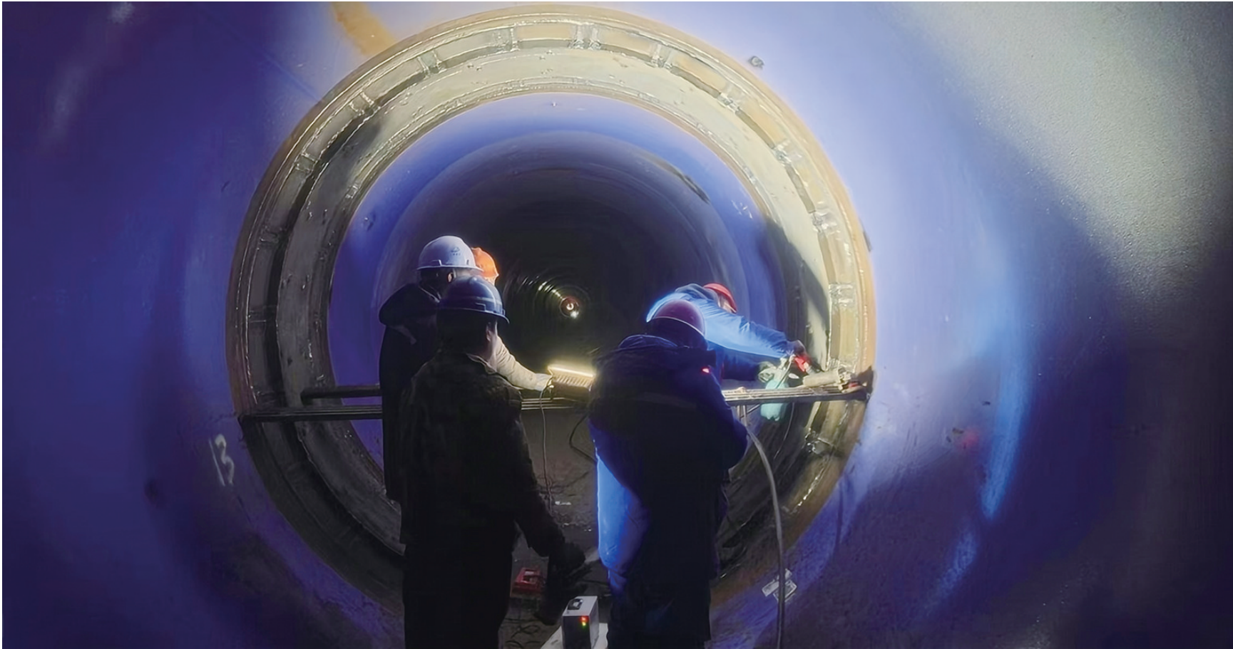
郑开同城郑州东部原水干管工程(一期)管道三方焊缝检测
