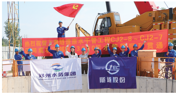
郑开同城东部供水工程郑州东部原水干管工程(一期)顺利穿越直径3米污水干管
